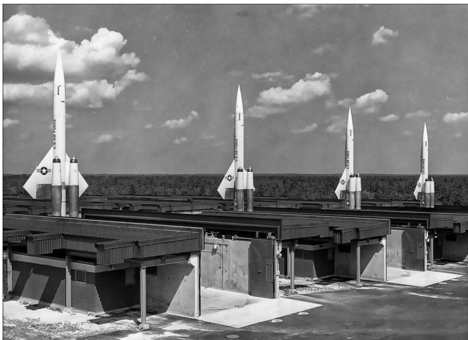
Illustration 29 : Voici à quoi ressemblaient les rampes de lancement des missiles Bomarc, telles que vues ici, en 1960, au New Jersey [Source : en. Wikipédia, onglet CIM-10 Bomarc]
