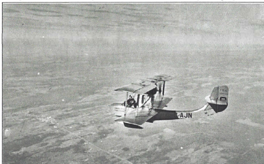
JN-4 Canuck de Curtiss utilisé pour la photo-aérienne construit au Canada en 1918
