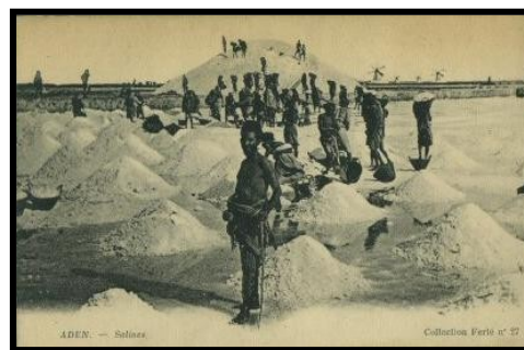
Illustration #65 : C'est grâce à l'énergie éolienne que l'eau de mer est remontée dans les bassins d'é- vaporation à Aden (1953). On reconnaît la silhouette des moulins (en haut à droite) sur cette carte postale des salines d'Aden.
